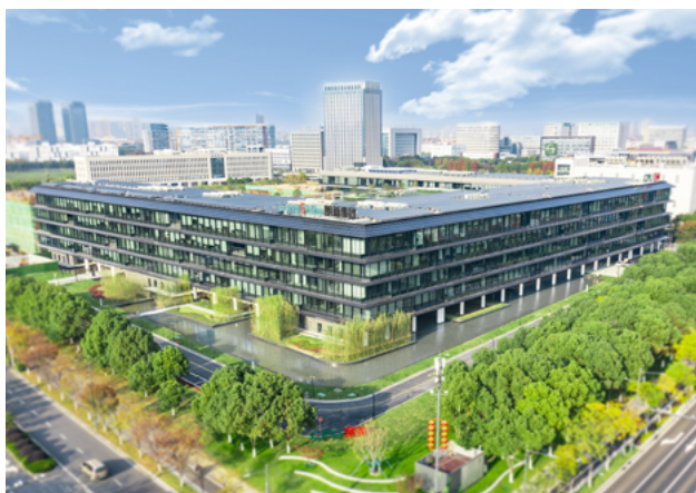
建设屋顶和挑檐光伏
