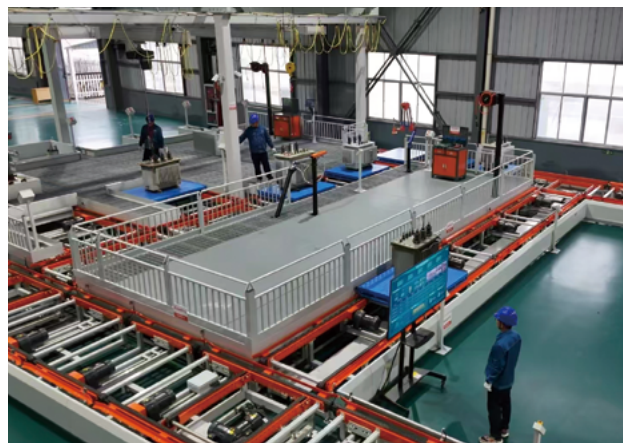
自主研发首条废旧变压器绿色拆解线
